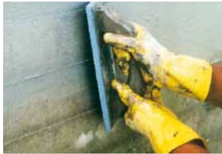
Sünger, sert kauçuk mala veya kaba tahta kalıp ile oluşturulan doku korunur
