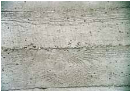
Düşük pigmentli bitiş (dolgusuz), boşlukları açık
