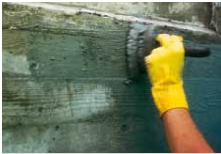
Fırça izleri, kaba tahta kalıp dokusu korunur
