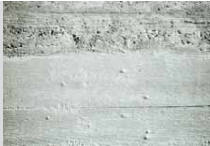
Sünger, sert kauçuk mala veya kaba tahta kalıp ile oluşturulan doku korunur
